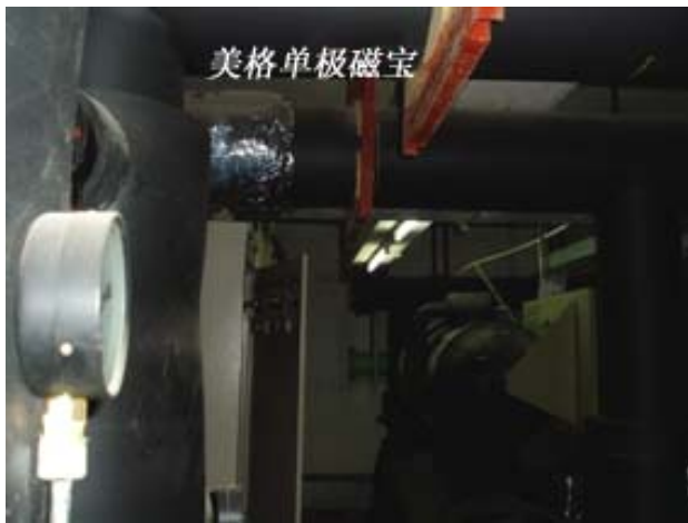
应用于空调冷冻水系统的美格单极磁宝(M-10Tri/S)
