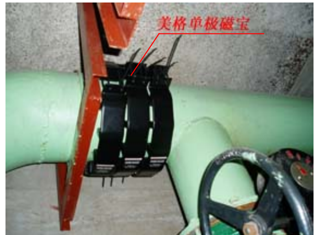
应用于空调冷却水系统的美格单极磁宝(M-10Tri/S)
