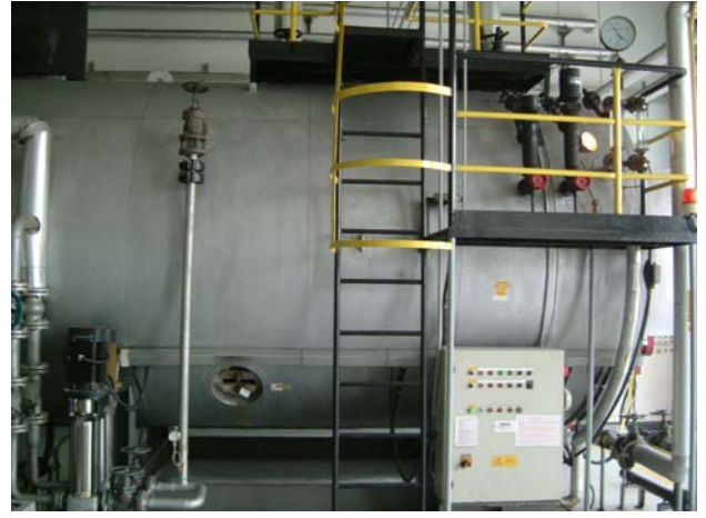
在进水管上安装美格单极磁宝水处理器
