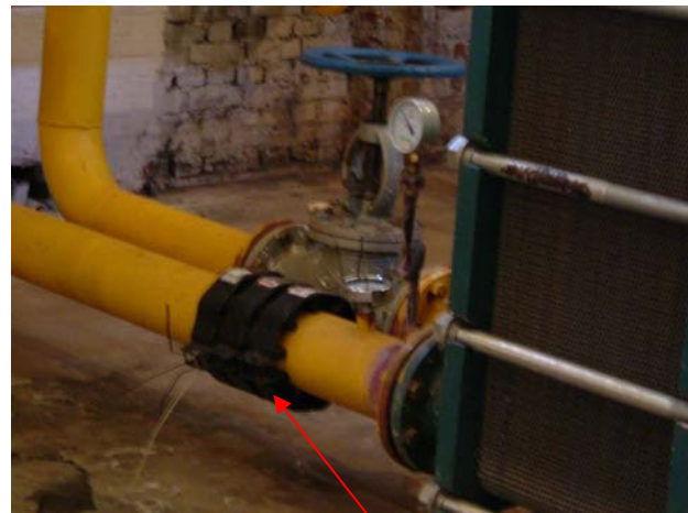
安装于热交换器进水管 (M-6Tri/S)
