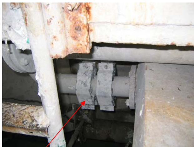
美格单极磁宝安装于洗瓶机进水管路上
