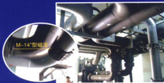
应用于空调冷却水系统的美格单极磁宝
